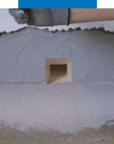
Гидроизоляция дренажных отверстий Drain Front
