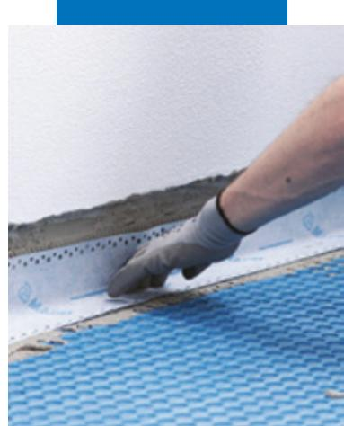
Гидроизоляция по краям с помощью **Mapeband Easy** на **Mapeguard WP Adhesive**
