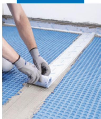
Гидроизоляция шовов между листами с помощью **Mapeband Easy** на **Mapeguard WP Adhesive**
